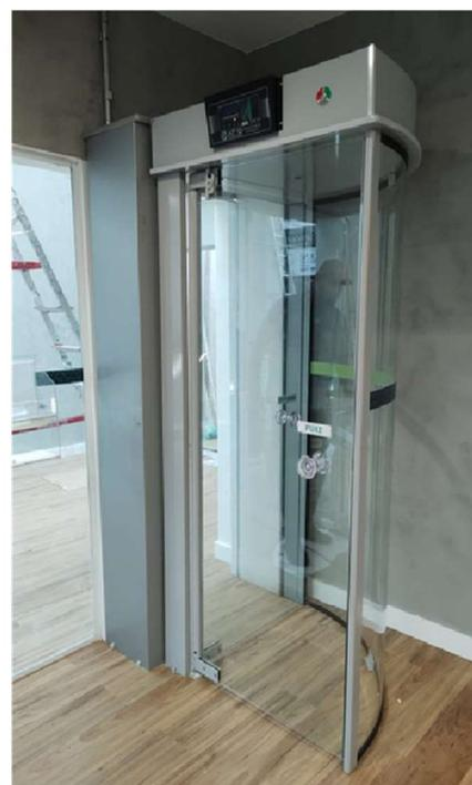
Possui um detector de metais de 08 zonas em sua entrada, realizando liberação de acesso apenas mediante a liberação pelo controle ou a não detecção de quantidade de metais.
